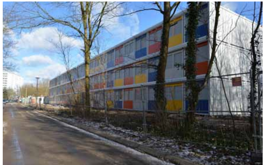
Die fertige Containerunterkunft in Buch.
